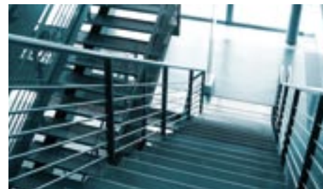
Automatische Treppenhausbeleuchtung über Bewegungsmelder und Dämmerungsschalter
